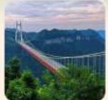
สะพานอ้ายจ้าย
